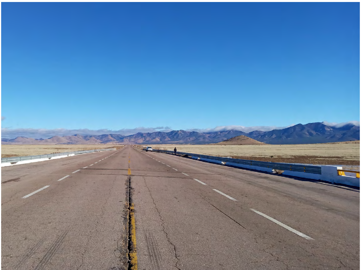
FIGURA 1. Carretera Federal 2, Agua Prieta, Sonora.
